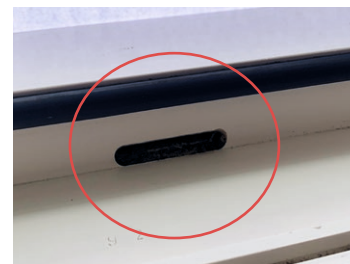
Afbeelding ontwatering sleuf binnenzijde.
