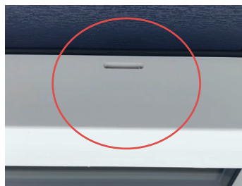
Afbeelding ontwatering sleuf buitenzijde.
